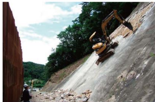
工事名称：国道375号忍原拡幅改築工事 施工場所：島根県大田市川合町忍原 発注機関：県央県土整備事務所
