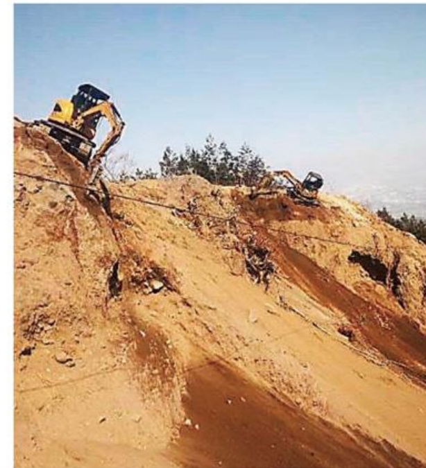
工事名称：奥地保安林保全緊急対策事業 施工場所：群馬県渋川市伊香保町 発注機関：渋川森林事務所
