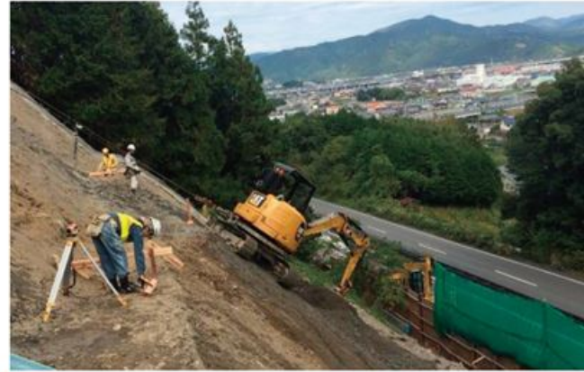
工事名称：国道1号線志戸呂工区法面修繕工事 施工場所：静岡県島田市 発注機関：中部地方整備局浜松河川国道事務所
