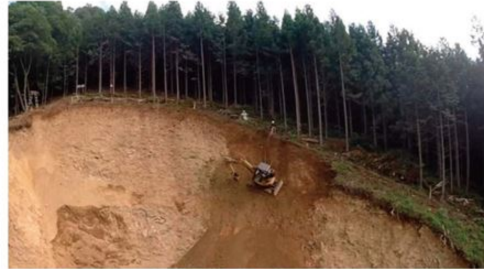
工事名称：葛野治山工事 施工場所：山梨県大月市 発注機関：富士・東部林務環境事務所
