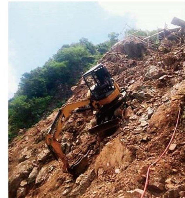
工事名称：葛葉下流山腹工法面工その6工事 施工場所：新潟県糸魚川市大所地先 発注機関：北陸地方整備局松本砂防事務所
