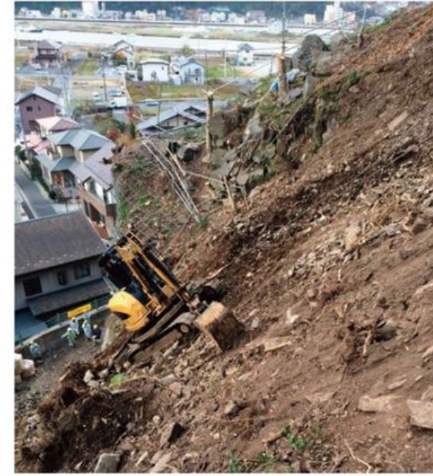
工事名称：牧山奥地保安林保全緊急対策工 施工場所：宮城県石巻市湊地内 発注機関：宮城県東部地方振興事務所
