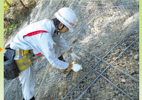
3 鉄筋組立工
